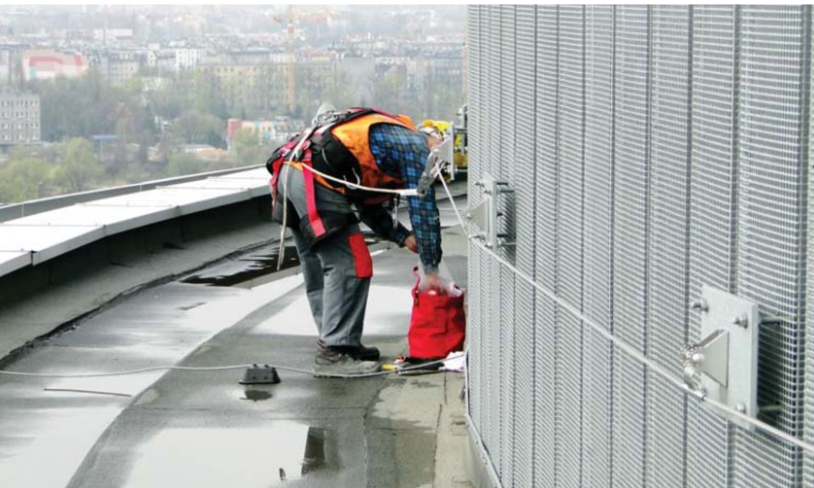
Příklad montáže systému DUO na povrch ploché střechy
